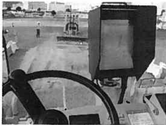
◀これが建設ロボット？ パソコンを操作し丁張りの杭を打たないで、計画高に押し固める技術を体験。
